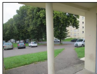
Photo N° 1090 AMIANTE CIMENT -- HALL EXTERIEUR Poteaux Coffrage perdu
